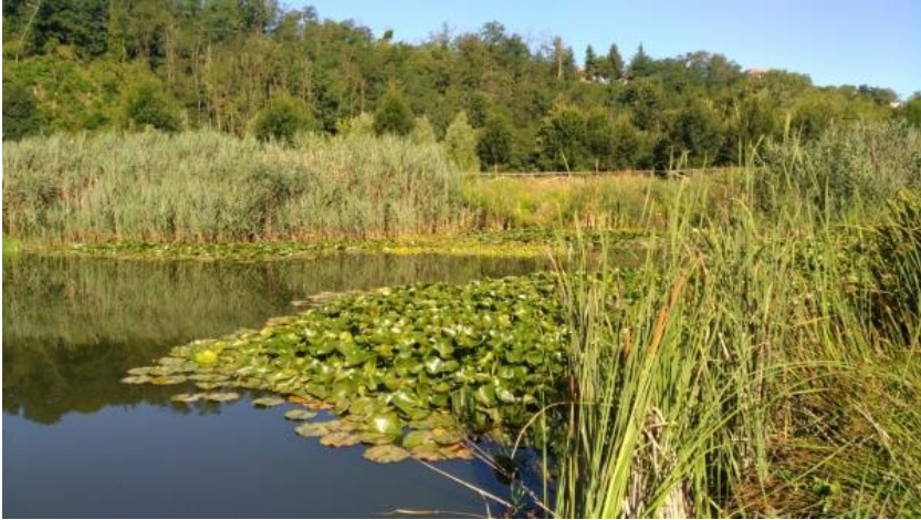
Rys. 59 Oczyszczalnia hydrofitowa dla ścieków z przelewów burzowych – Gorla Maggiore, http://www.globalwettech.com/media/k2/items/cache/474f4cdd4383ff91fd1d98bcb039d93b_L.jpg
