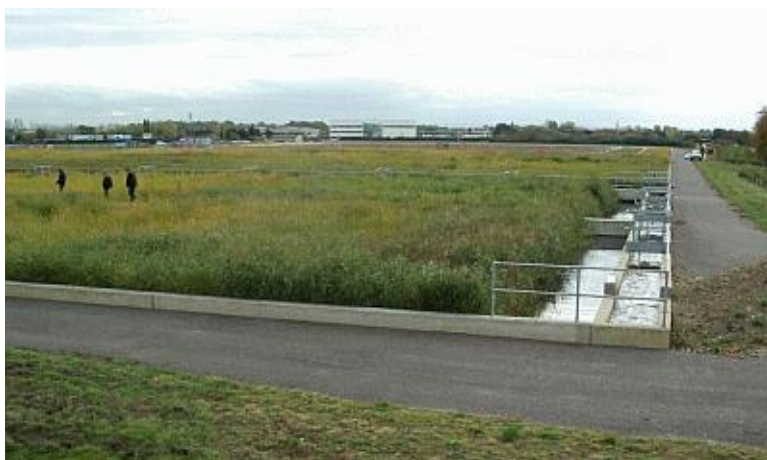
Rys. 56 System hydrofitowy do oczyszczania spływu powierzchniowego z portu lotniczego Heathrow, Wielka Brytania https://warwick.ac.uk/fac/sci/eng/research/group/water/research/completed/hcw/
