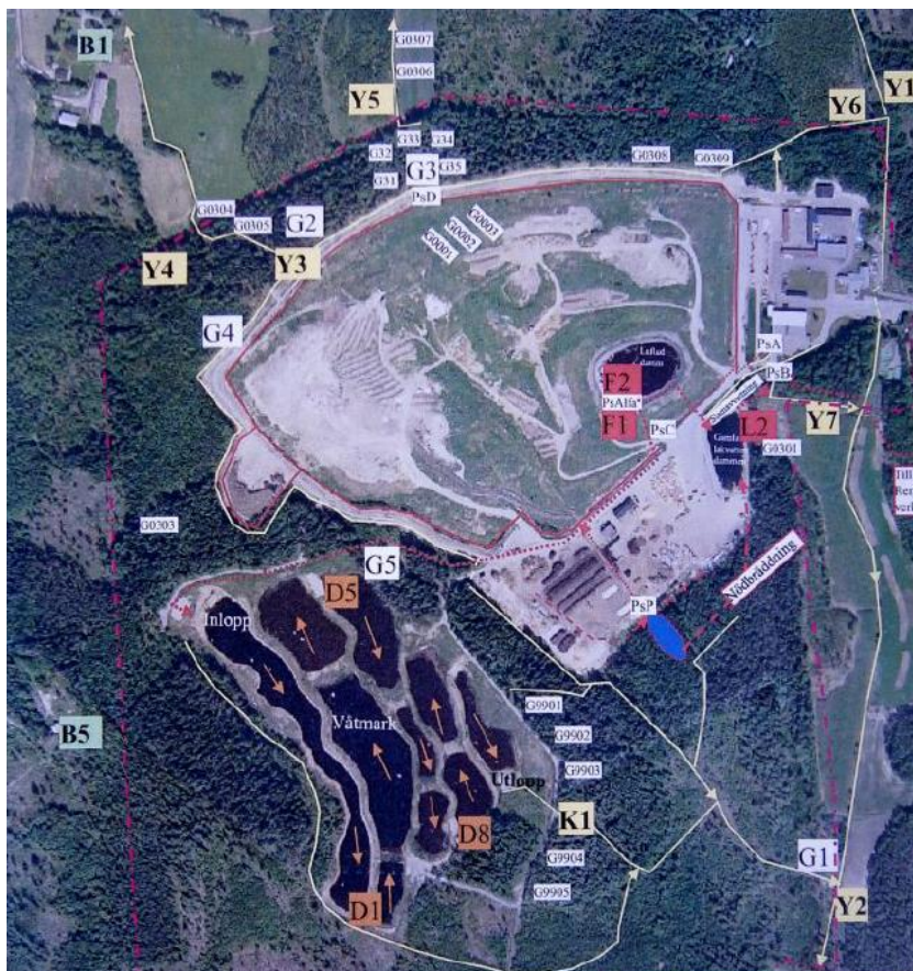
Rys. 64 Widok na składowisko odpadów oraz obiekt hydrofitowy do oczyszczania odcieków w Atleverket w Szwecji. Źródło: Bandaruk (2015).
