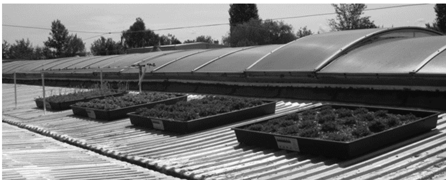
Rys. 1- Stanowiska badawcze zielonych dachów o różnej konstrukcji (Sobczyk i Mrowiec 2016).
