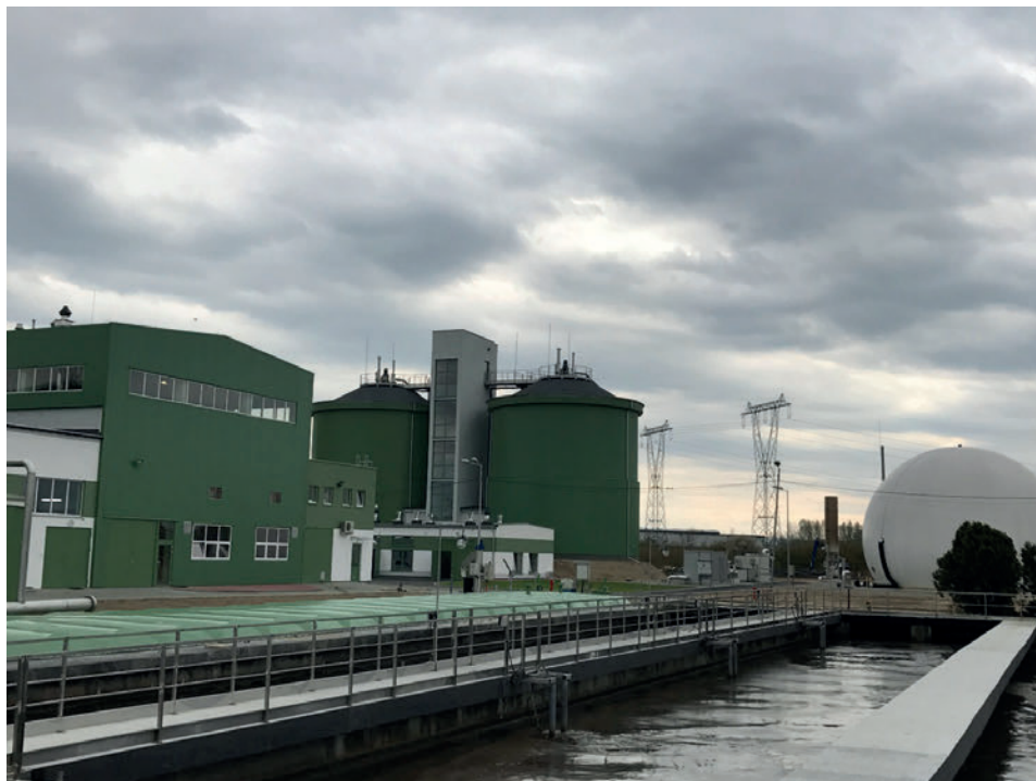
Rys.34. Zakład przeróbki osadów opartej o hydrolizę termiczną i fermentację w Tarnobrzegu
