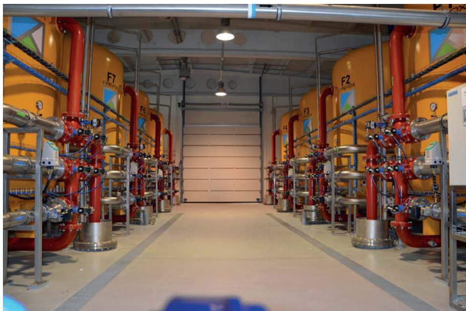
Rys. 30. Stacja Uzdatniania Wody „Cedron” w Wejherowie
