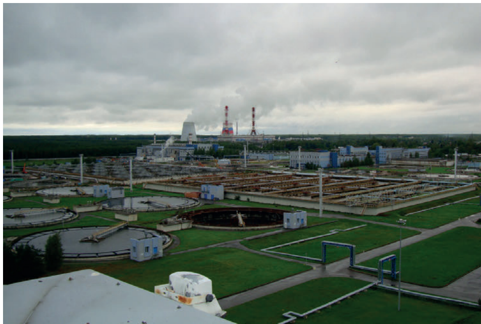
Rys. 24. Widok oczyszczalni „Południowo-Zachodnia” w Petersburgu (fot. M. Gromiec)
