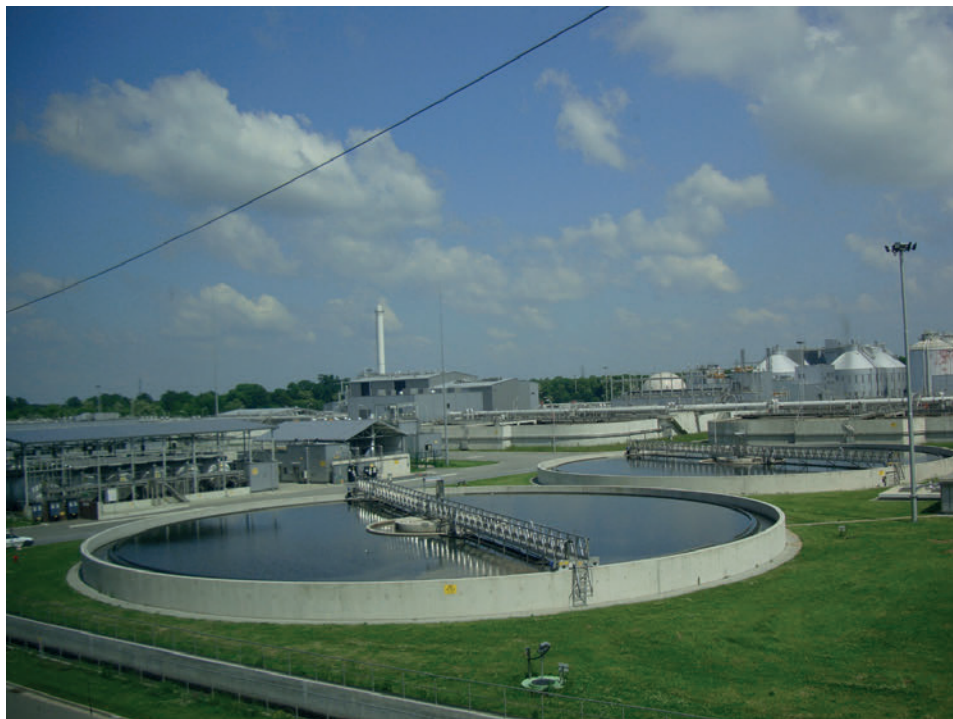
Rys. 17. Oczyszczanie ścieków na oczyszczalni „Czajka” w Warszawie (fot. M. Gromiec)
