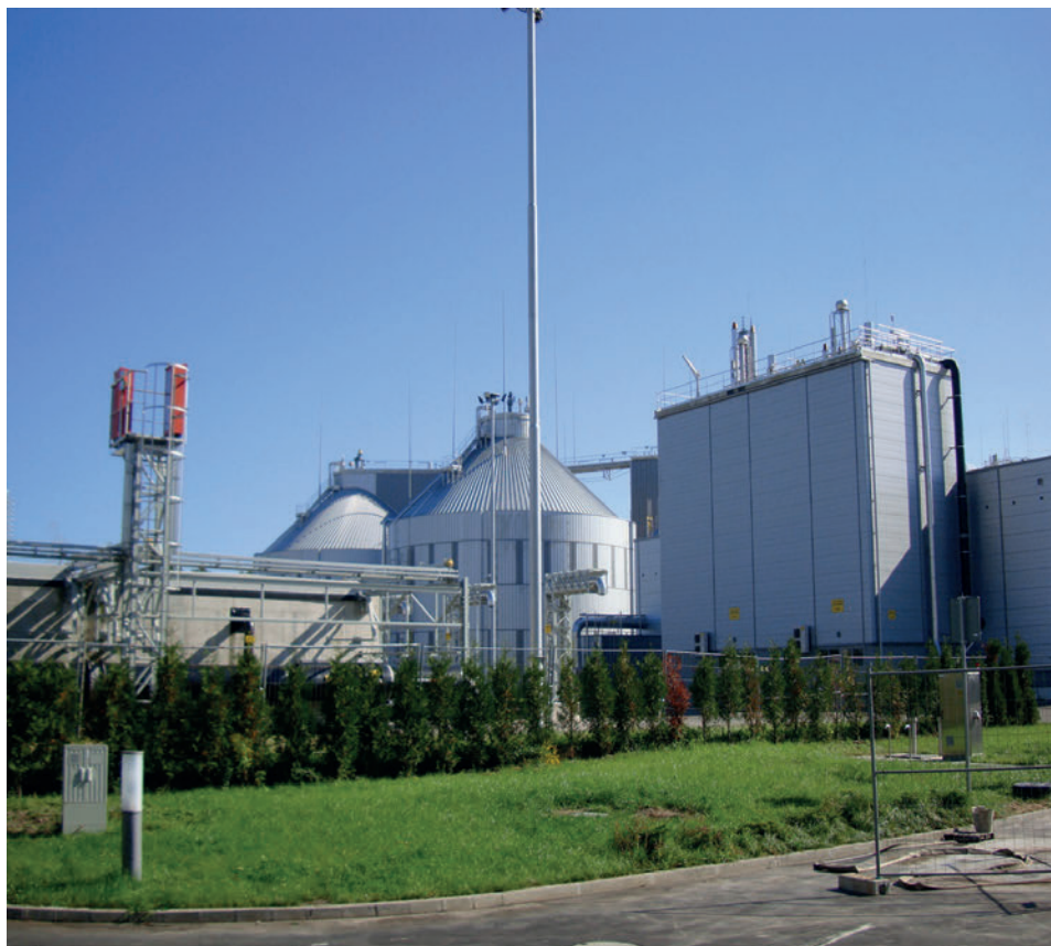
Rys. 18. Stacja termicznej przeróbki osadów ściekowych na oczyszczalni „Czajka” (fot. M. Gromiec)
